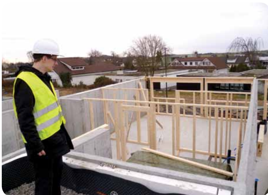
Dag Olav Stensland følger ivrig med på husbyggingen. (Foto: Vidar Haagensen)
