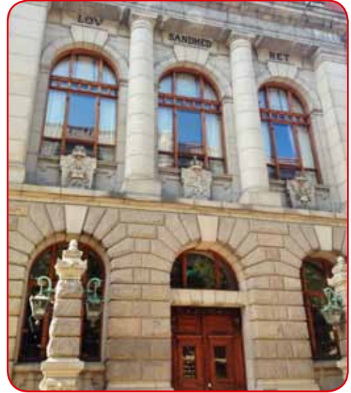
Høyesterett holder til i denne bygningen i Oslo sentrum. (Foto: Tina Jerstad)
